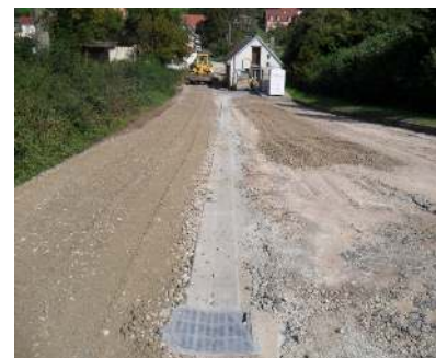
Mise en place des caniveaux
